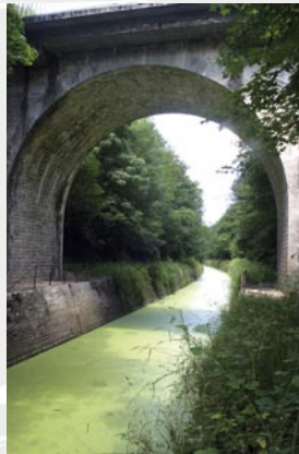
La tranchée d'AUGY
